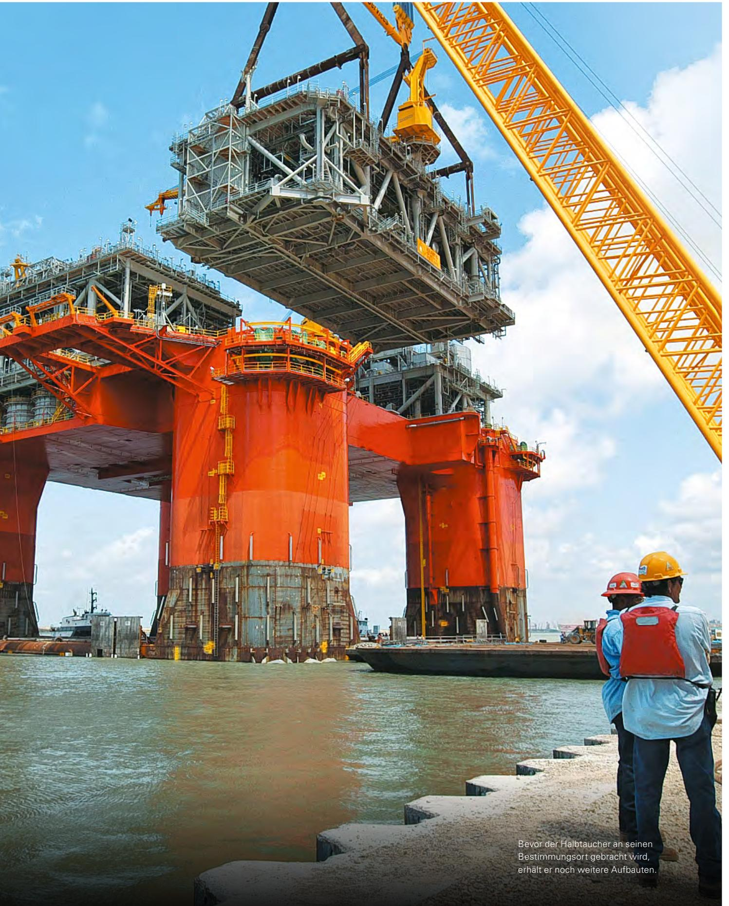
Bevor der Halbtaucher an seinen Bestimmungsort gebracht wird, erhält er noch weitere Aufbauten.
