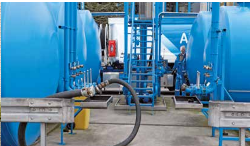
Mit einem blauen Tank begann die ‚Ehe‘ zwischen Aral und Pludra. Heute stehen hier ein paar mehr blaue Tanks.
